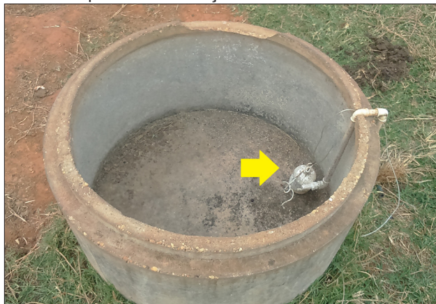
Figura 5 - Bebedouro de manilha vazio evidenciando o esquema de instalação de boia flutuante
