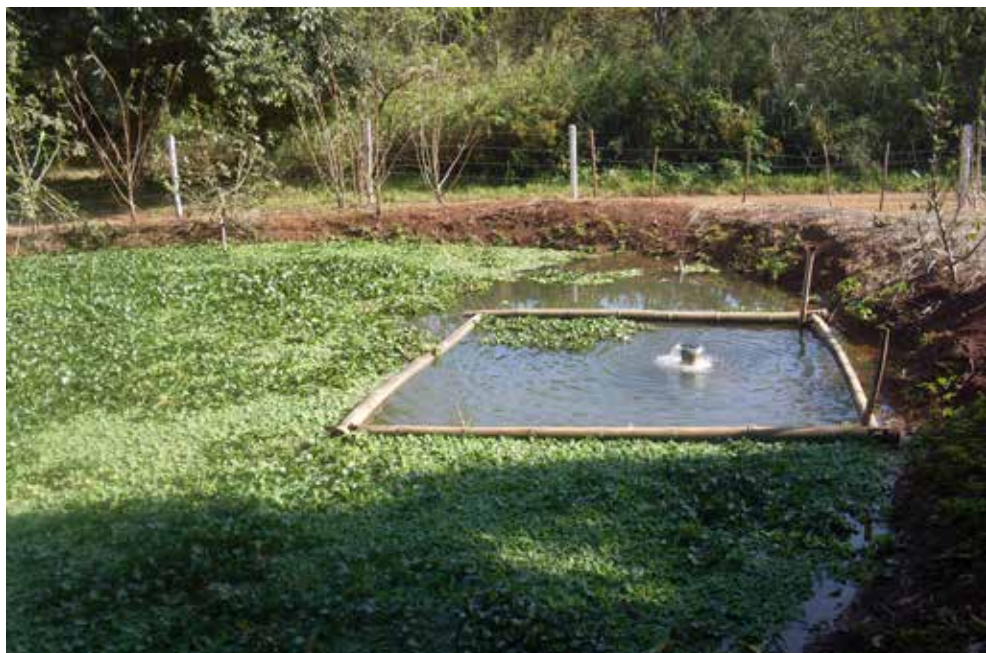
Figura 12 - Segunda bacia, de tratamento da água, coberta com aguapés e orelhas-de-onça
