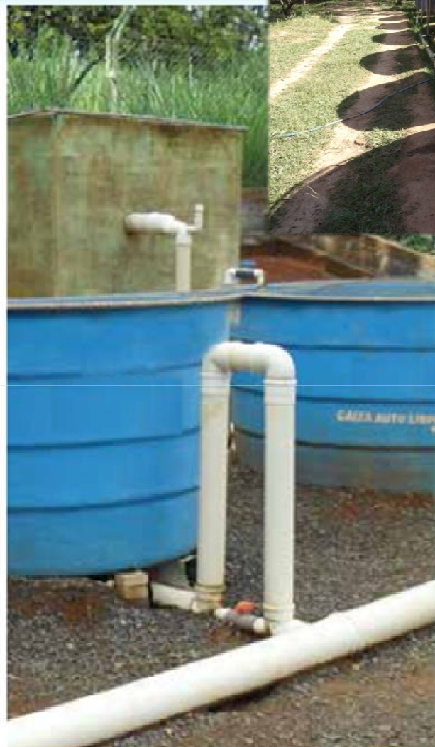
Figura 10 - Tubo coletor da água efluente das caixas de produção (150 mm)
