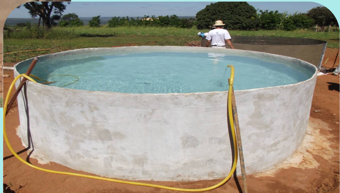
Tanque de ferro-solo-cal-cimento
