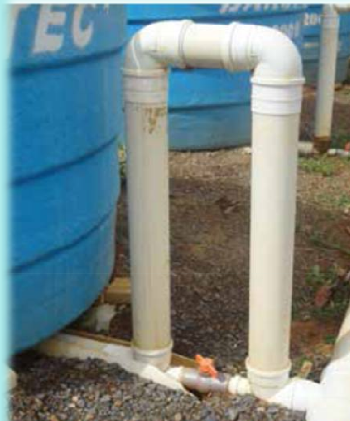
Figura 9 - Sistema de esvaziamento das caixas de produção
