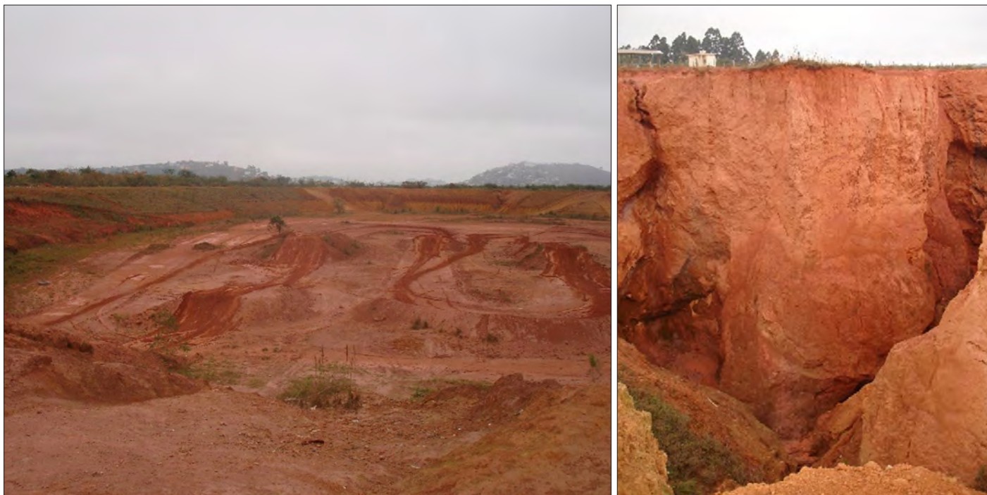
Figura 6 - Construção de estádio esportivo em alto de encosta – Juiz de Fora, MG
