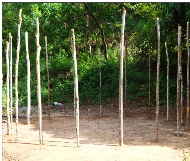
Figura 2 - Escoras pelo interior da circunferência para montagem do reservatório de água
