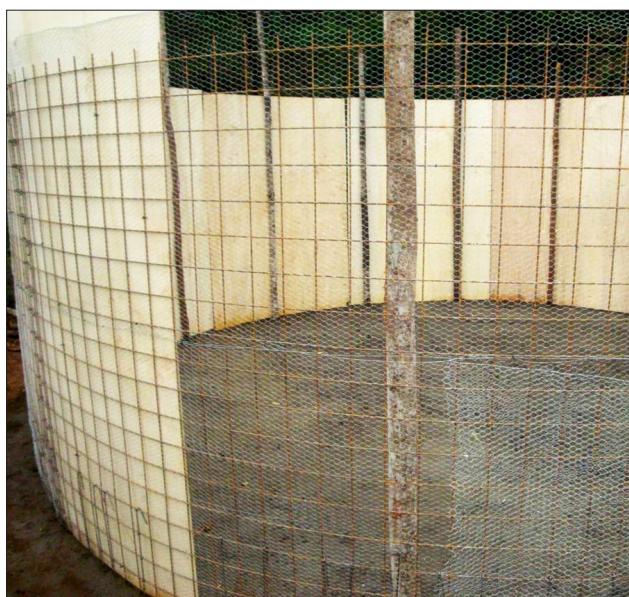
Figura 3 - Instalação da ferragem na base do reservatório em formato de círculos formando uma malha
