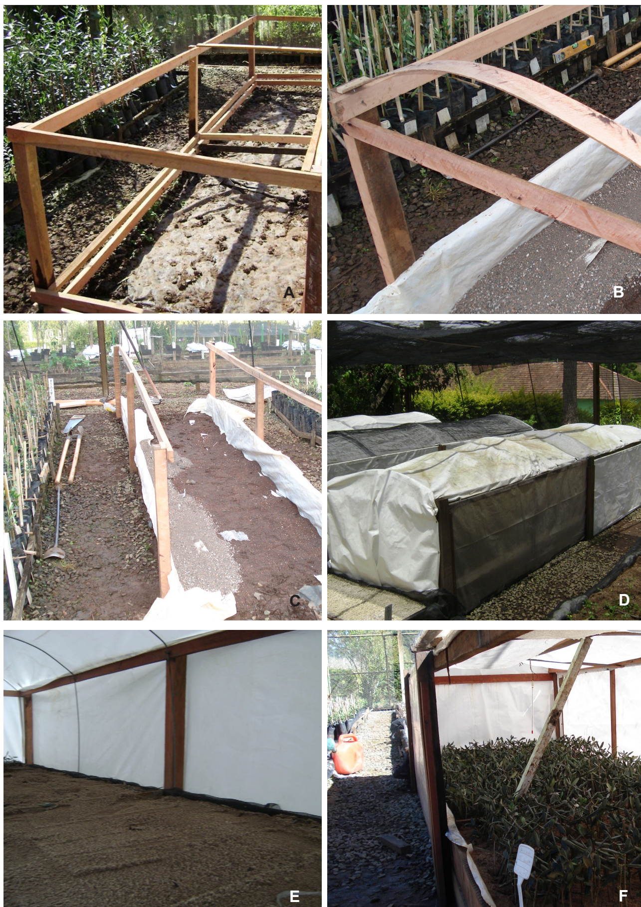
Figura 2 - Processo de construção da estufa
