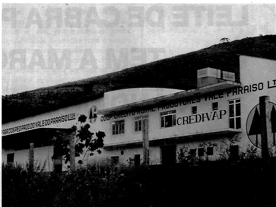
Vista parcial da CREDIVAP.
