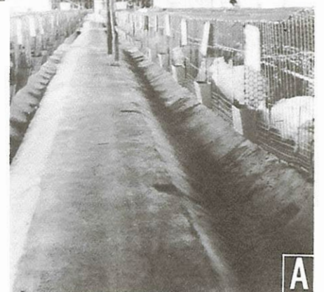
Fossa com sistema de drenagem para coleta de fezes e urina.
