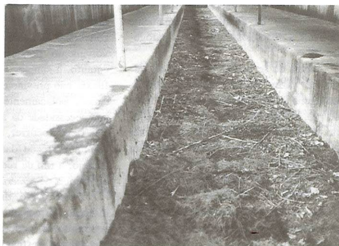
A construção de valas coletoras de fezes com eficiente sistema de drenagem é importante, pois assim o processo de esporulação fica dificultado.
