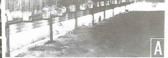
Galpão fechado (vista externa).
