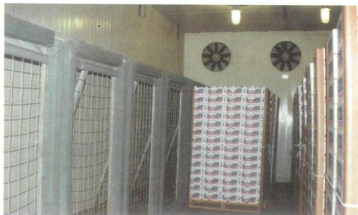
Figura 60 - Pré-resfriamento de uvas finas de mesa em câmara de ar forçado pelo sistema palete-a-palete
