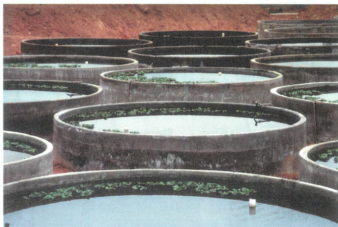
Figura 7 - Tanques circulares de concreto utilizados no cultivo intensivo de peixes ornamentais na Zona da Mata Mineira
