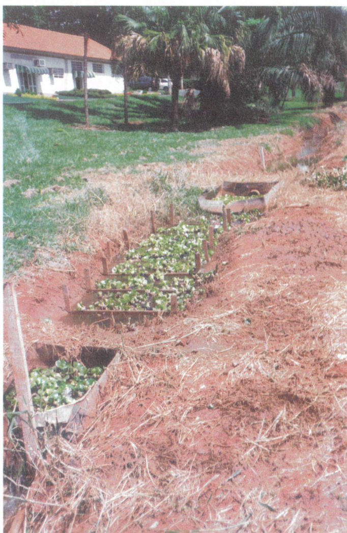
Figura 4 - Biofiltro de macrófita aquática ( Eichhornia crassipes )
