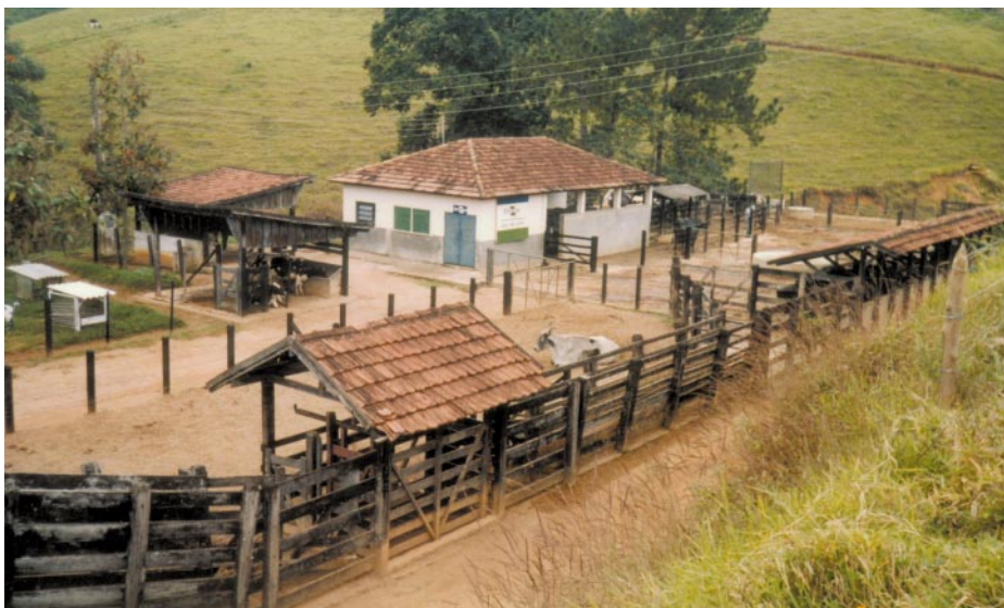
Figura 6 - Vista geral das instalações
