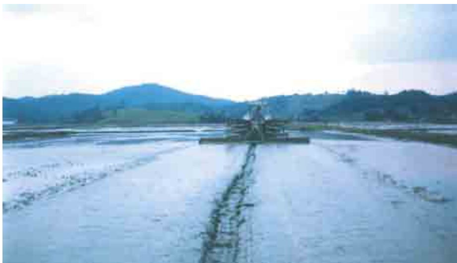
Figura 4 - Alisamento final e sulcamento para drenagem superficial
