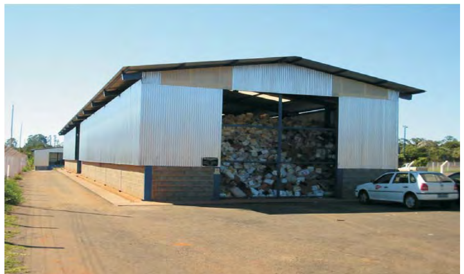
Figura 3 - Vista geral do galpão da Central de Recebimento de Embalagens de Uberaba
