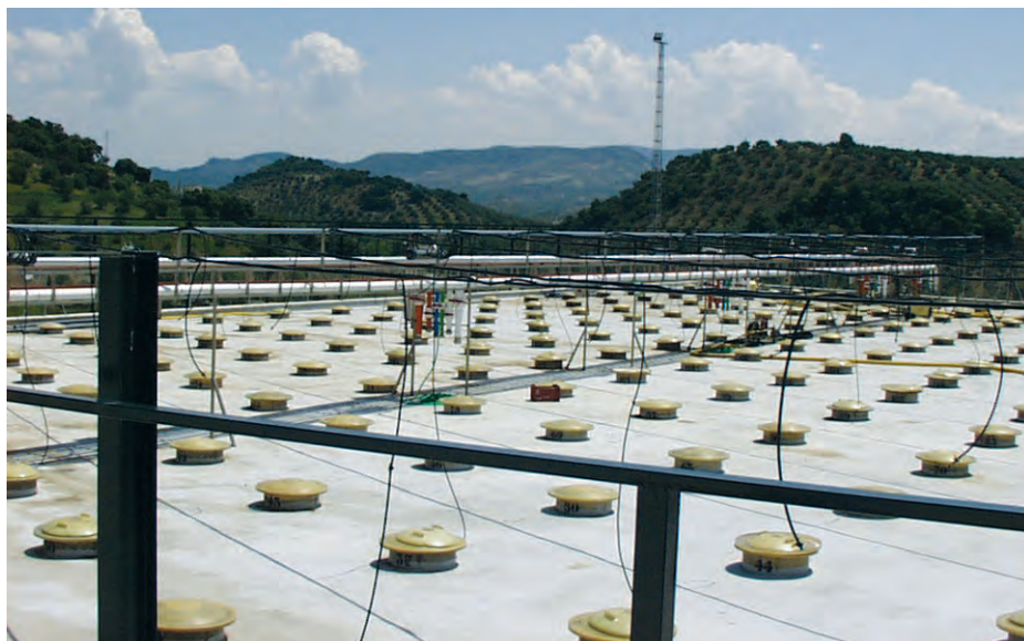
Figura 3 - Pátio com contenedores de fermentação
