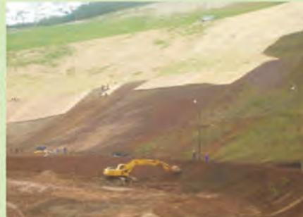
Foto 11 - Área recuperada com técnicas de bioengenharia com uso de biomantas de diferentes resistências, drenagem e bermas artificiais.
