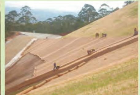
Foto 12 - Estágio final do término dos trabalhos mostrando a proteção com biomantas e o início do desenvolvimento da vegetação.
