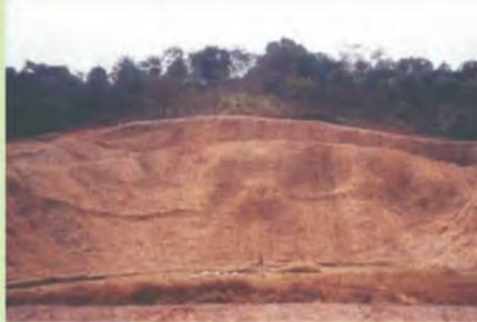
Foto 8 - Controle da erosão com técnicas de bioengenharia utilizando biomantas, bermas artificiais com Bermalonga e vetiver.
