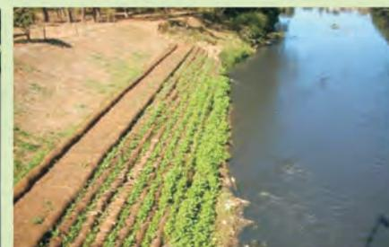
Foto 5 - Margem do rio recuperada com o sistema "solo envelopado verde" utilizando o mesmo solo da erosão, biomanta georreforçadora, estacas vivas e sementes.
