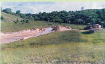
Foto 2 - Trabalho de desassoreamento do curso d'água e recuperação das áreas degradadas com Bioengenharia.
