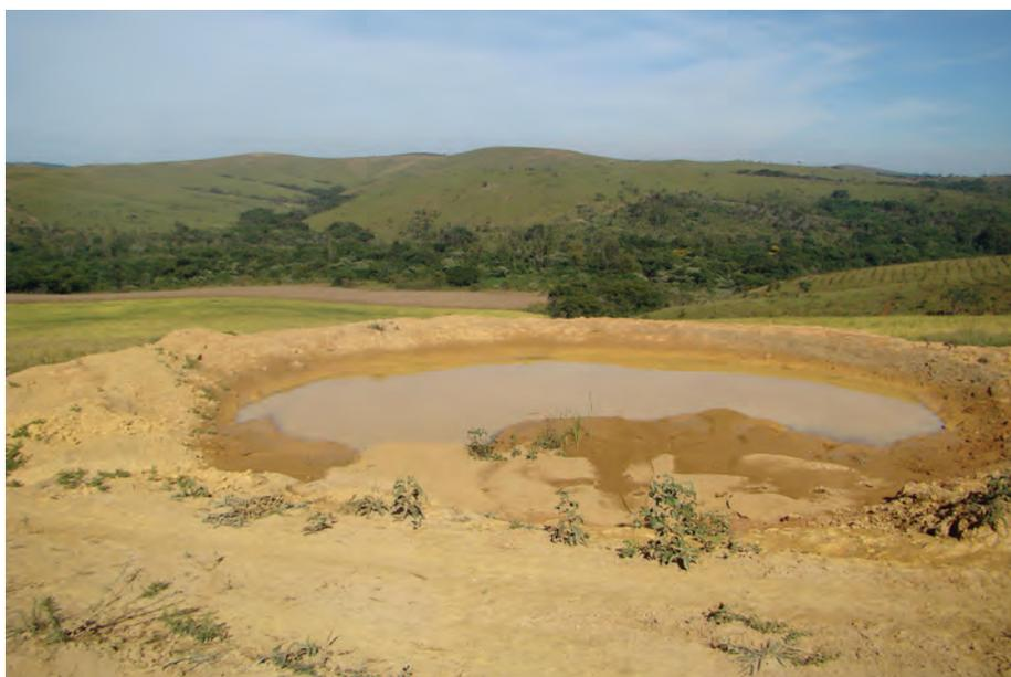
Figura 2 - Bacia de captação para controle erosivo
