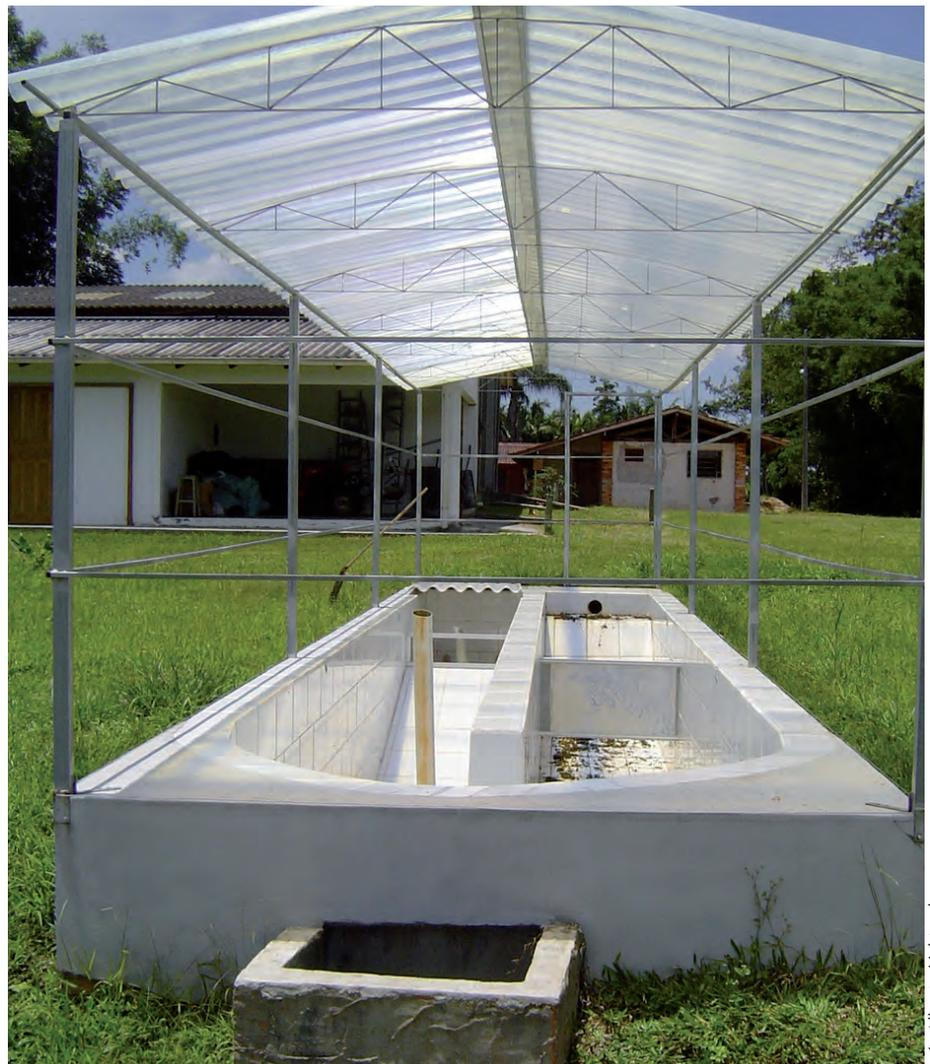
Figura 6 - Tanques auxiliares para decantação de resíduos e separação da “cica”
