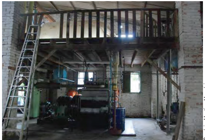
Figura 4 - O gás metano é armazenado em uma grande bolsa plástica (andar superior) e utilizado pelo conjunto motogerador para produção de energia elétrica
