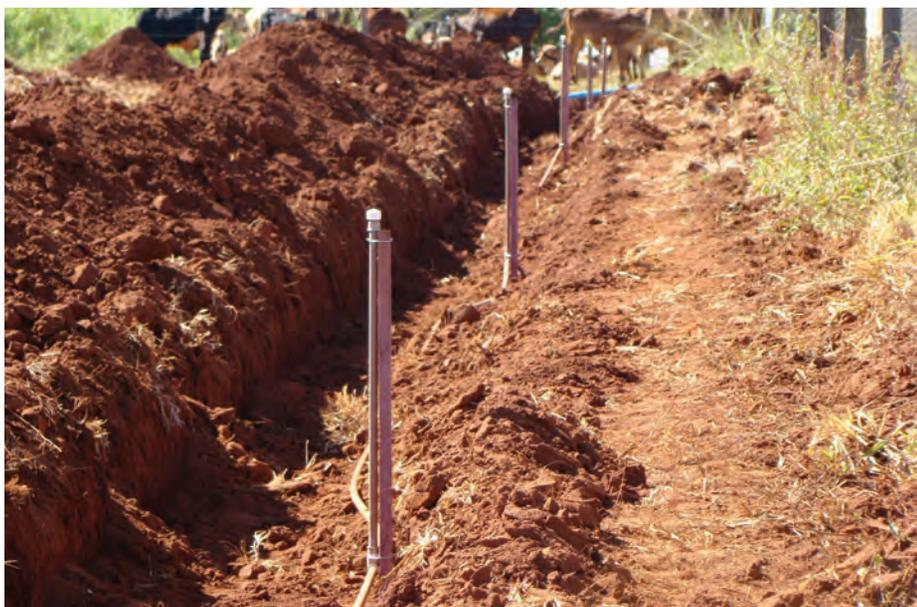
Figura 2 - Valas abertas no solo acolhendo linha lateral de irrigação com tubos de polícloroeto de vinila (PVC) de 25 mm de diâmetro, constituídos de pontos de subida da água
