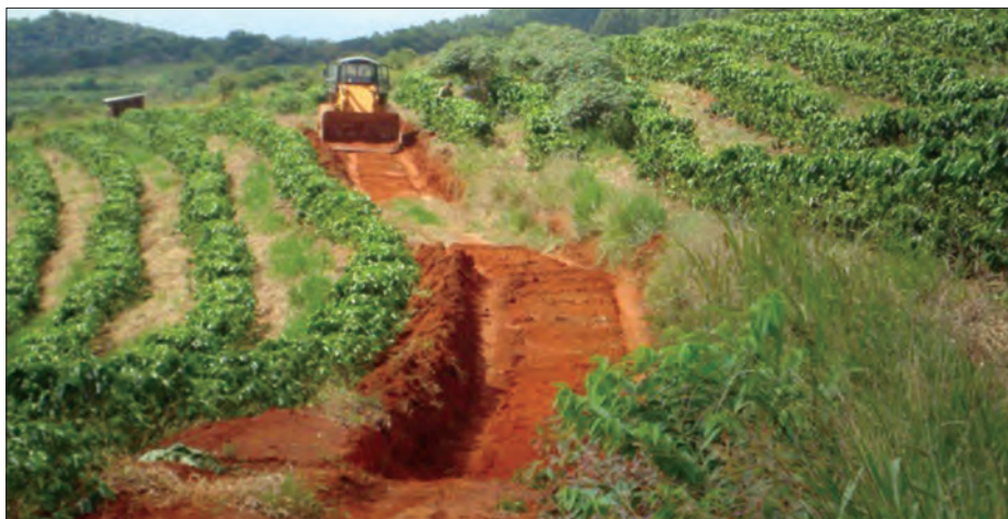
Figura 5 - Caixa de captação construída em áreas de uso agrícola
