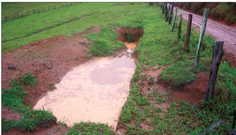
Figura 4 - Caixa de captação ao longo da estrada
