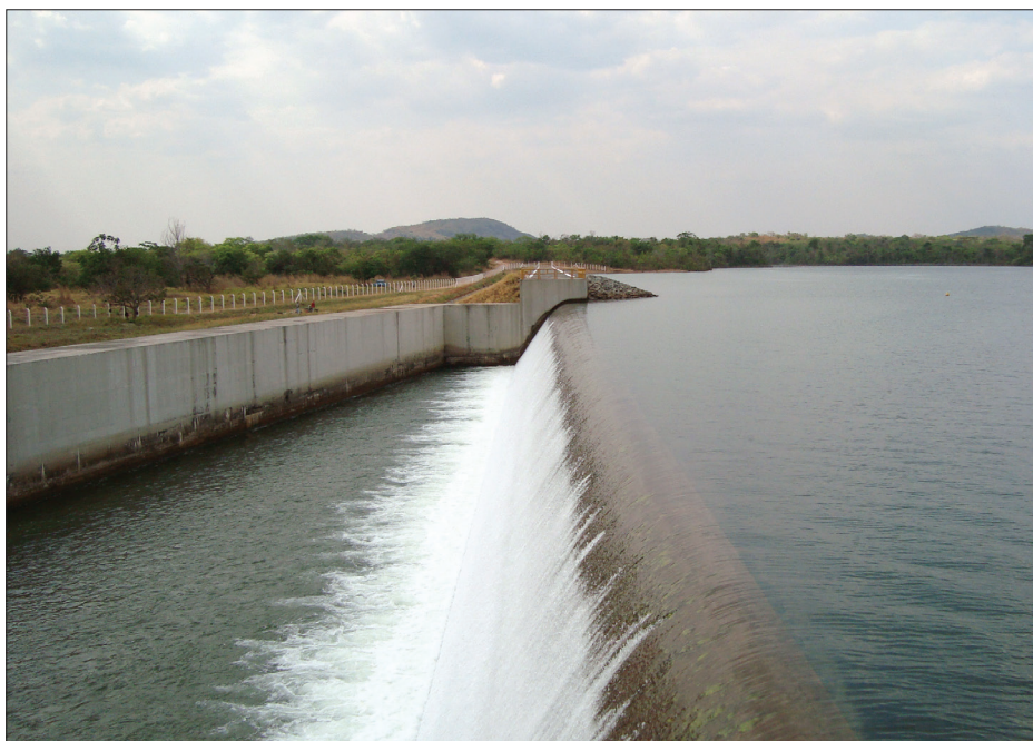
Figura 5 - Reservatório de regularização de vazão
