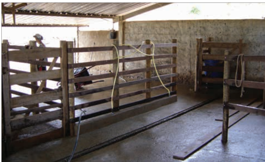
Figura 4 - Sala de ordenha com piso com declividade adequada e canaleta para escoamento de água e resíduos
