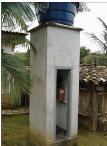
Figura 6 - Abastecimento de água clorada para a sala de ordenha
