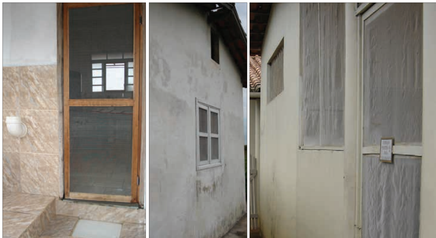
Figura 4 - Telas milimetradas nas aberturas externas para evitar entrada de insetos e outras pragas
