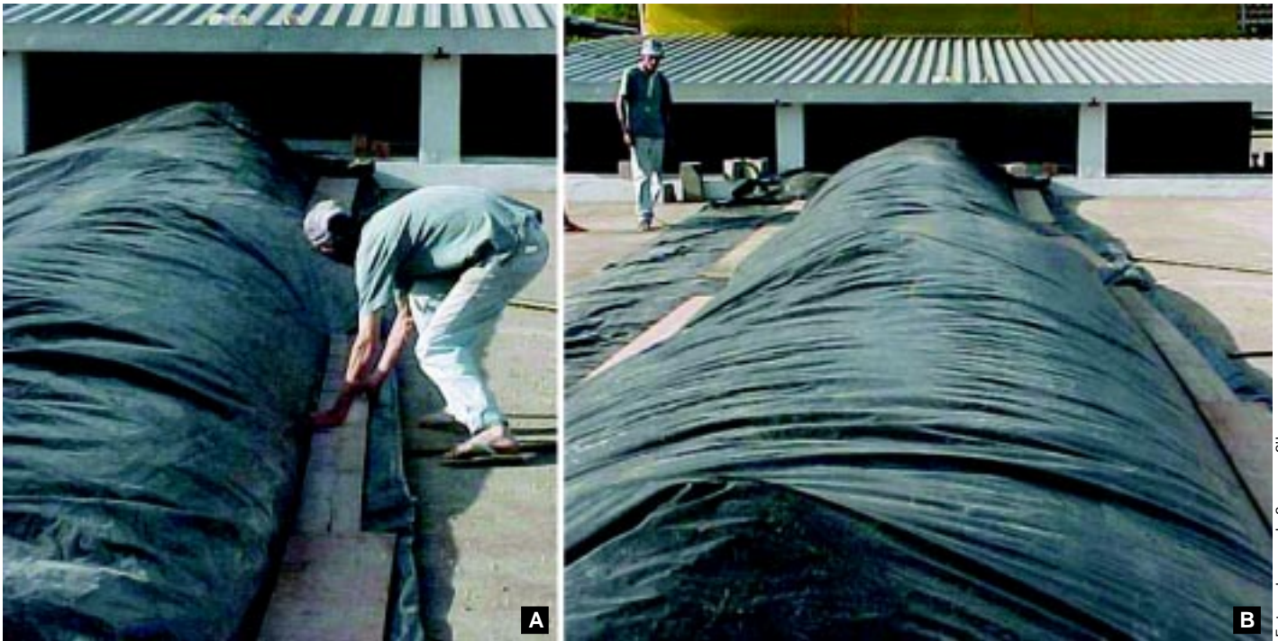
Figura 14 - Terreiro híbrido com cobertura de polietileno para o período chuvoso
