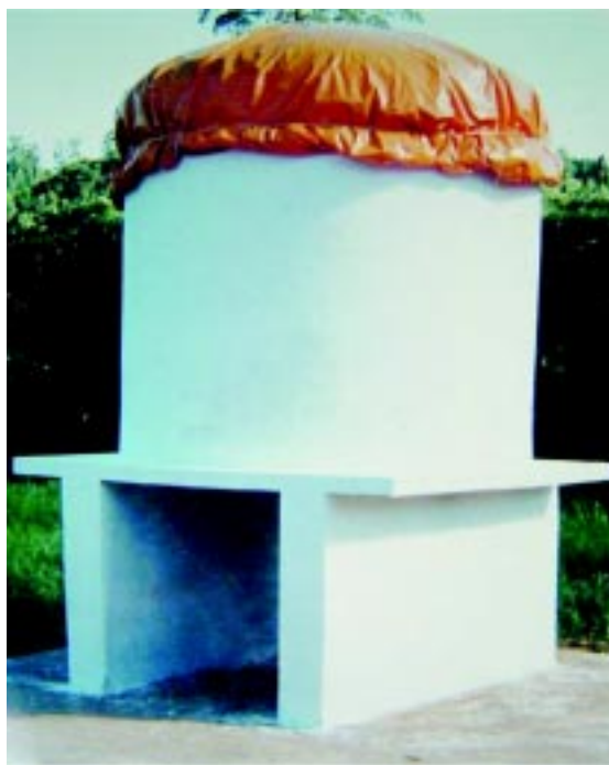
Figura 20 - Silo armazenador com descarga central
