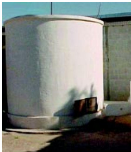
Figura 16 - Silo secador-armazenador
