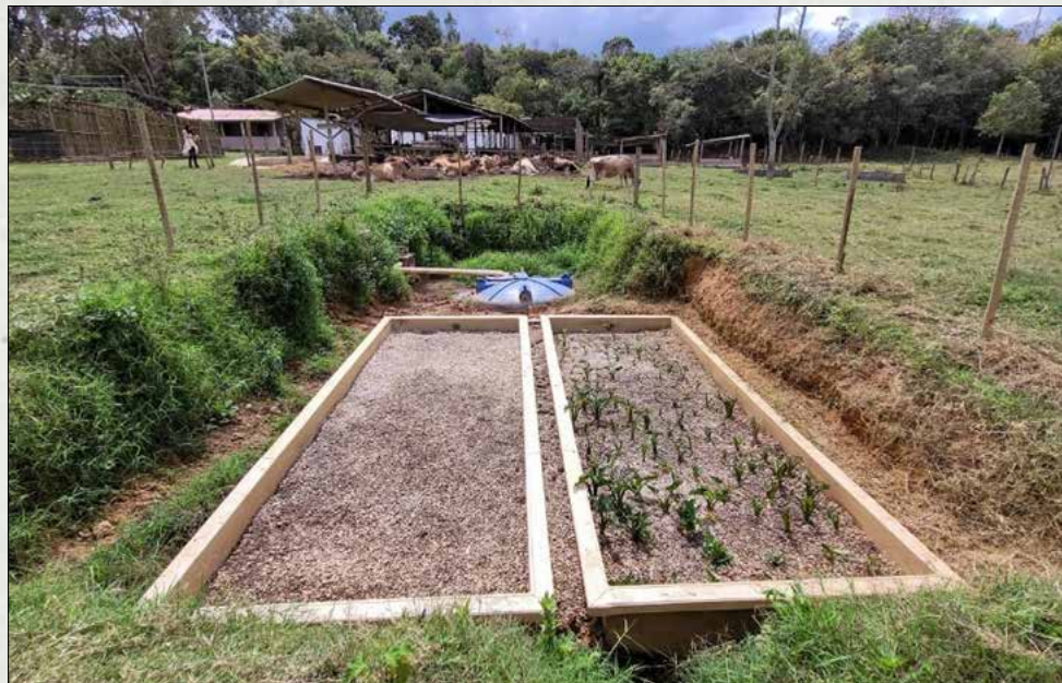
Figura 2 - Sistema Alagado Construído de fluxo horizontal
