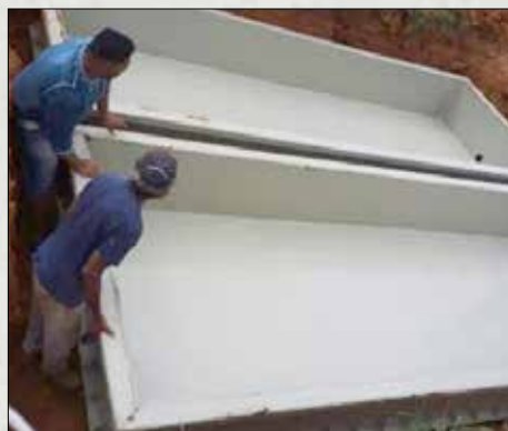
Figura 19 - Assentamento dos tanques no solo
